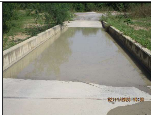
ภาพที่ 3.38 บ่อล้างล้อรถบรรทุก
